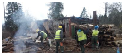
Воспитанники программы демонтируют здание
